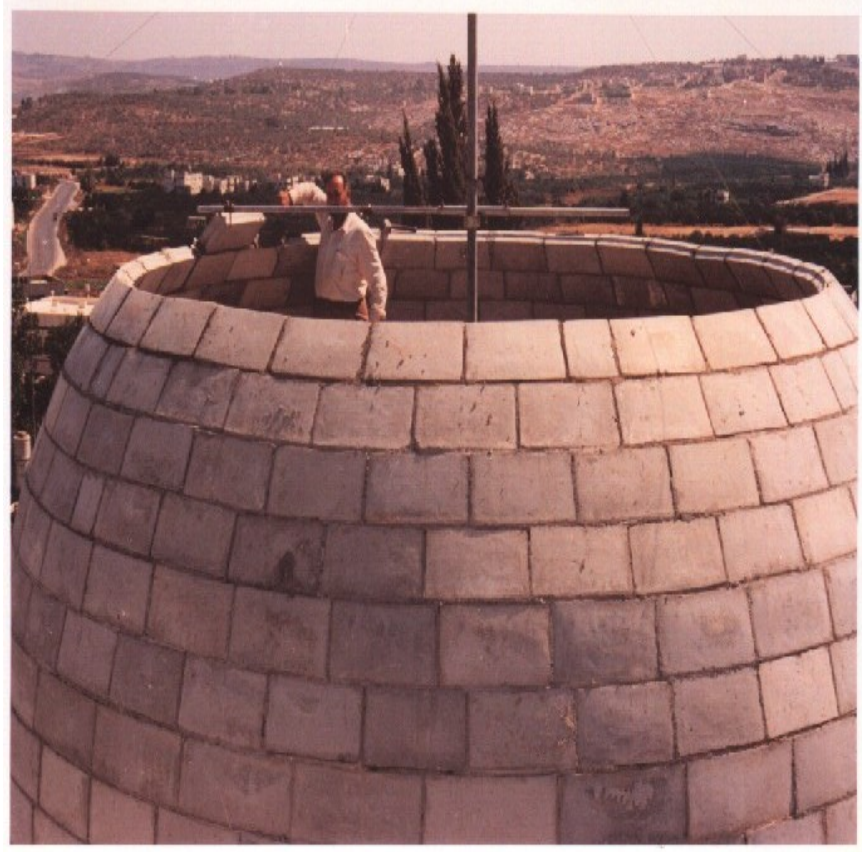
شكل (١١): عملية بناء المداميك بالاستعانة بالبيكار
