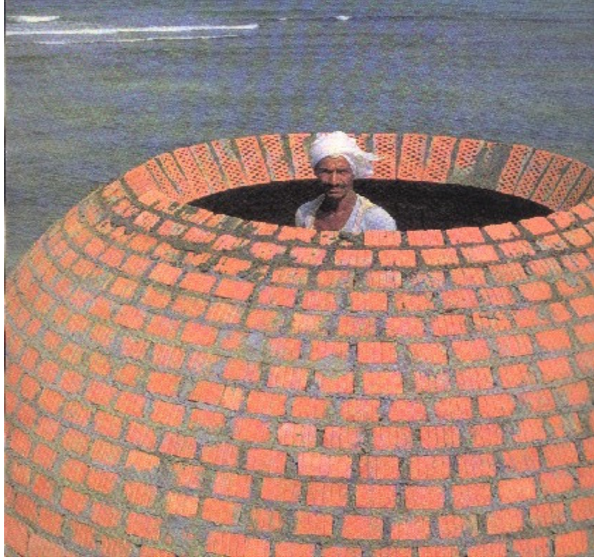
شكل (٦): عملية بناء قبة مسجد الكورنيش في مدينة جدة
